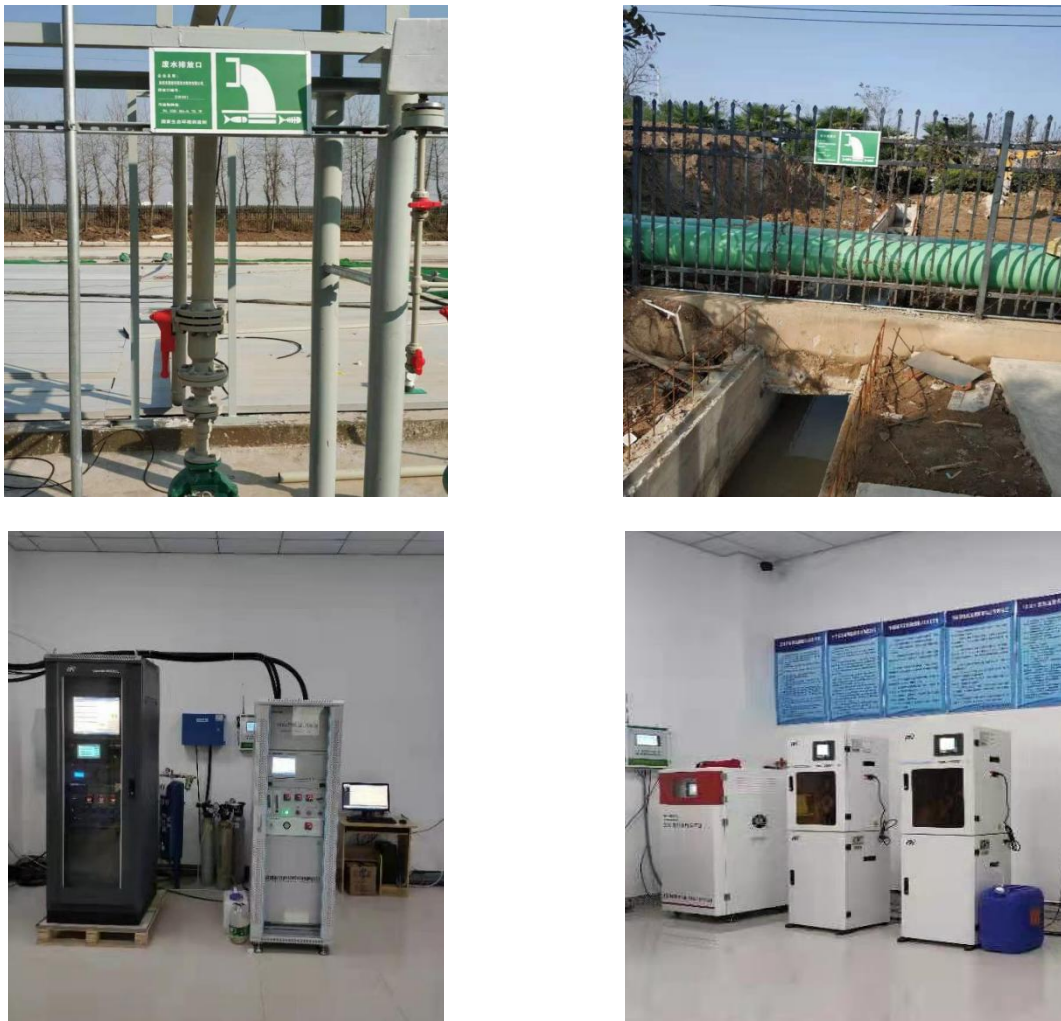
图 4.2-3 废水采样口及环保标识牌和在线监测分析系统
